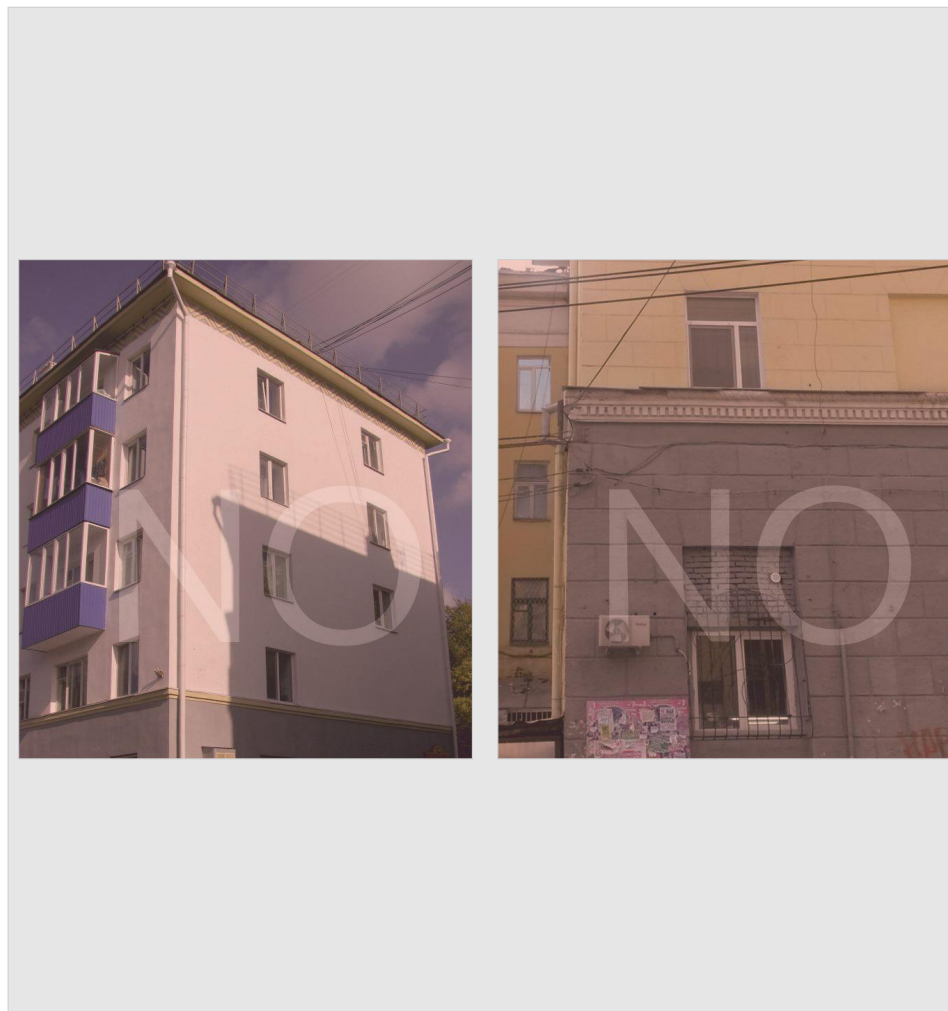
Рис. 4.2.1. Фасады с недопустимым изменением оконных проёмов
