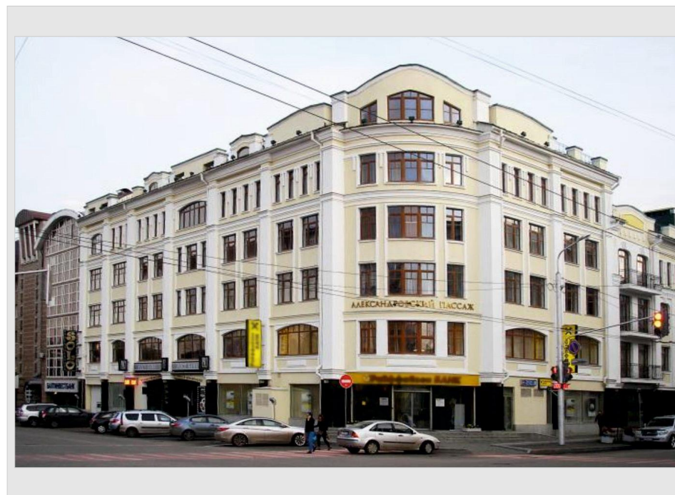
Рис. 3.1 Фасад здания в надлежащем состоянии
