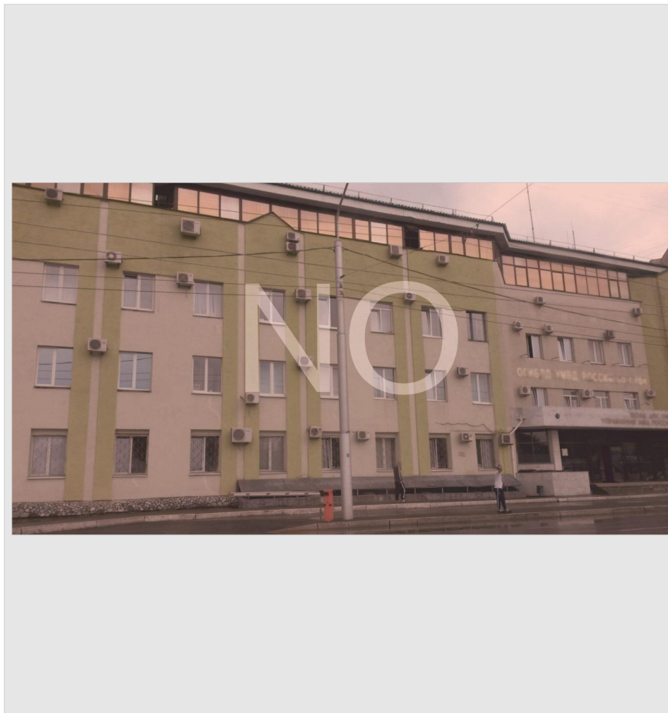
Рис. 4.4.1. Применение недопустимого способа крепления наружных блоков кондиционеров
